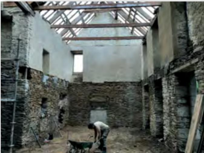
La toiture a été déposée. La charpente mise à nu a été recouverte d'une bâche pour se protéger des intempéries. Ainsi les sols ont pu être préparés pour procéder au coulage d'une dalle en béton. Au fond à gauche, nous pouvons observer une niche découverte lors du retrait des enduits anciens, qui servait vraisemblablement à accueillir un lit clos. Elle sera transformée en une ouverture qui permettra un accès direct entre le rez-de-chaussée du Presbytère et le théâtre de verdure.
