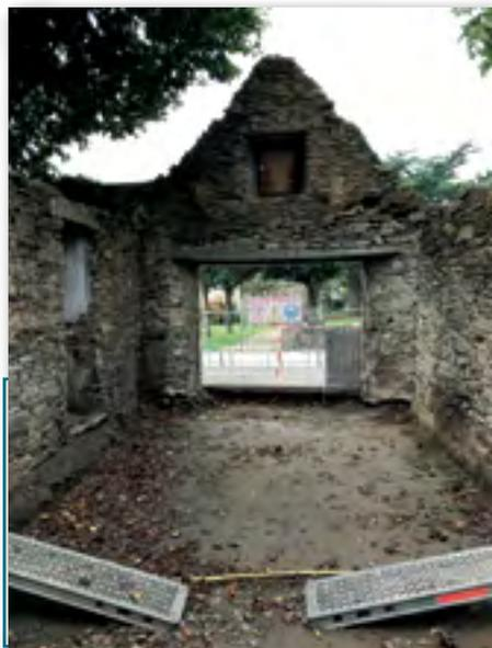
Le pignon sud du petit garage a dû être démonté en raison de faiblesses structurelles visibles ici sur le côté droit. Il sera reconstruit à l'identique et consolidé avec la pose d'un nouveau linteau.
