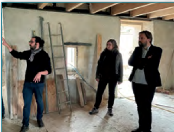
Vue intérieure du RDC de l'ancien presbytère avec son plafond où alternent poutres bois et acier.
