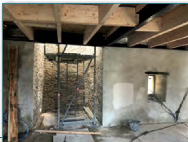
Vue du mur Nord du RDC avec sa cage d'escalier vidée de toute menuiserie et test sur le mur de la couleur de l'enduit de chaux.
