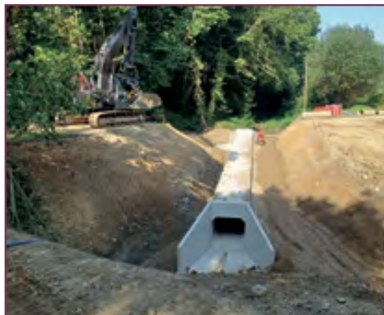
Exemple de pont cadre
